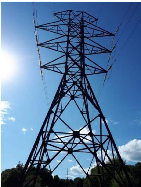
Q: 测量时需要某个目标点到地面的高度信息，且目标点悬空无法放置棱镜，如图中电力应用时，需要测得输变电电缆最大弧垂处离地面的高度。
